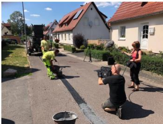
(Abbildungen: Einbau von ASPA Gussasphalt)
