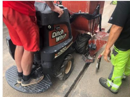
(Abbildungen: Verfüllen des Trench mit Flüssigboden)
