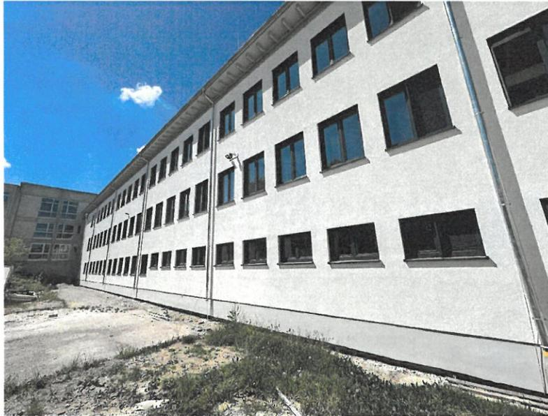
Die Südfassade des Nordtraktes ist fertigverputzt.
